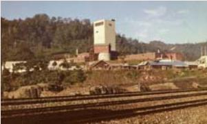
昭和36年着工、昭和40年6月に完成しました。立坑上部に巻き上げ機を備えた日本で二ヶ所しかない珍しい運搬立坑です。総工費17億円、立坑は垂直に掘り下げる坑道のこと、基本的にエレベーターと同じです。
